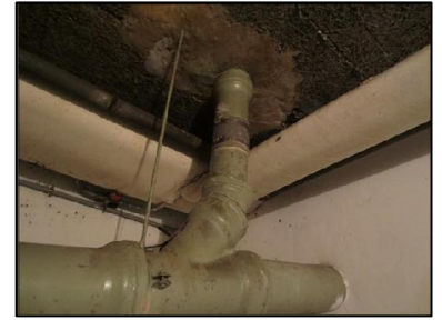
Photo N° 652 ECH-N°2 CALORIFUGEAGE --COULOIR DE CAVE Conduits de fluide Laine minérale + enveloppe plâtrée
