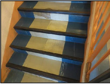
Photo N° 650 ECH-N°4 REVETEMENT DE SOL --ESCALIER CAVE ET PALIER ESCALIERS Dalles de sol 30x30 avec colle jaune
